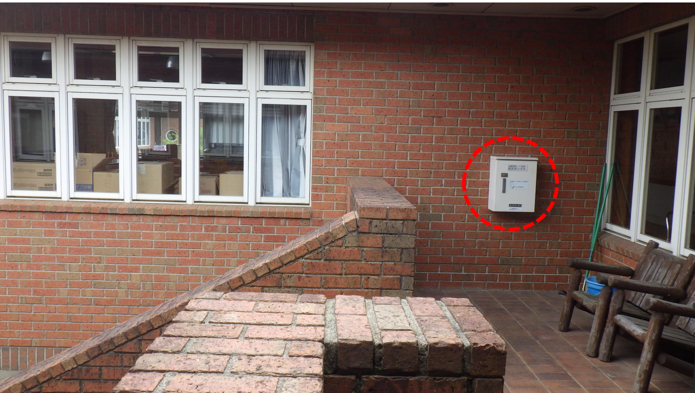
若葉台小学校 北側校舎二階入口付近
