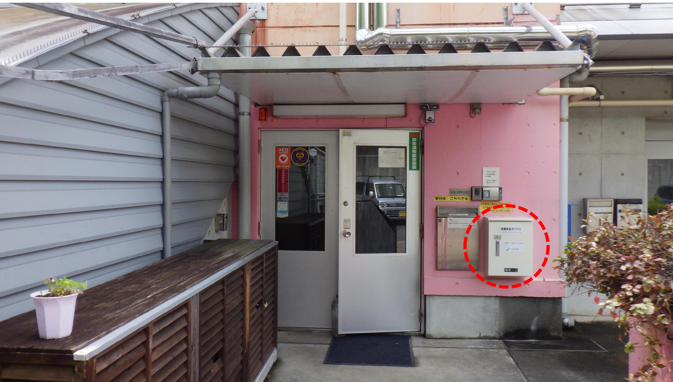
長峰小学校 校舎北側入口インターホン付近（北側駐車場）
