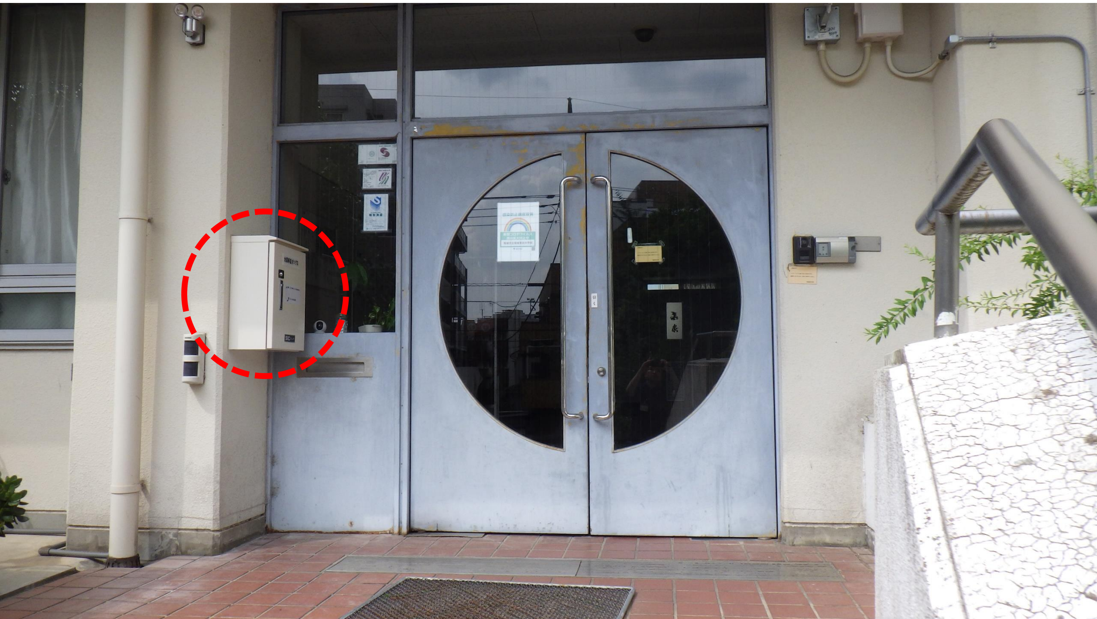
稲城第四中学校 校舎南側二階来客用玄関ポスト付近
