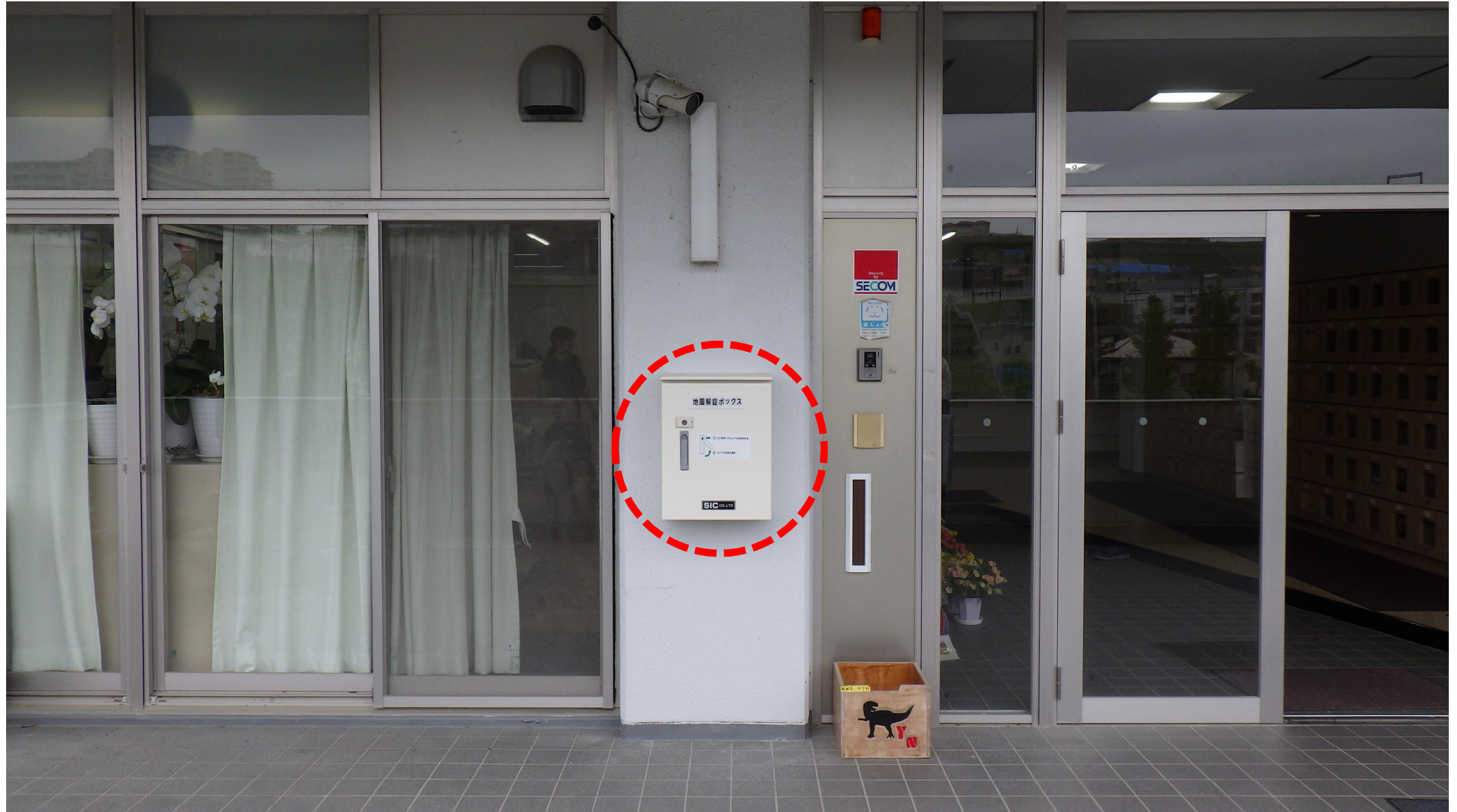
稲城第三中学校 グラウンド側校舎二階来客用玄関インターホン付近
